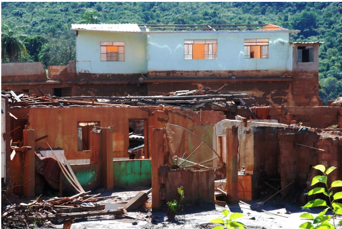
Imagem 4: Destruição no distrito de Bento Rodrigues – cinco meses e 12 dias após o vazamento de lama da Samarco no município de Mariana em Minas Gerais. Foto: Erivam de Oliveira – em 17/04/2016
