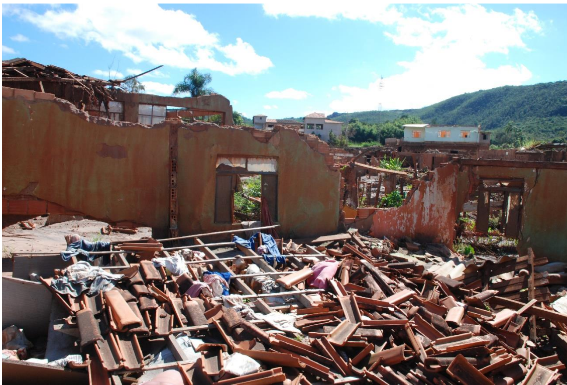
Imagem 3: Destruição das casas no distrito de Bento Rodrigues – cinco meses e 12 dias após o vazamento de lama da Samarco no município de Mariana em Minas Gerais.
